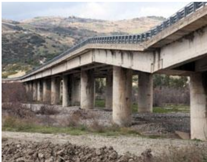
Fig.75. Ponte sul Basento
