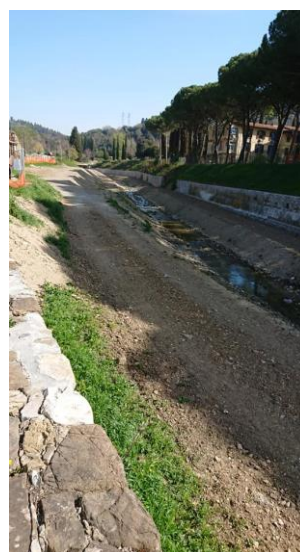
Figg. 59 e 60. Canale nella piana fiorentina 1.4.2019 Taglio raso della vegetazione e modifica sponde
