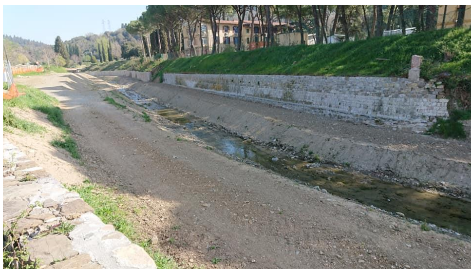
Figg. 59 e 60. Canale nella piana fiorentina 1.4.2019 Taglio raso della vegetazione e modifica sponde
