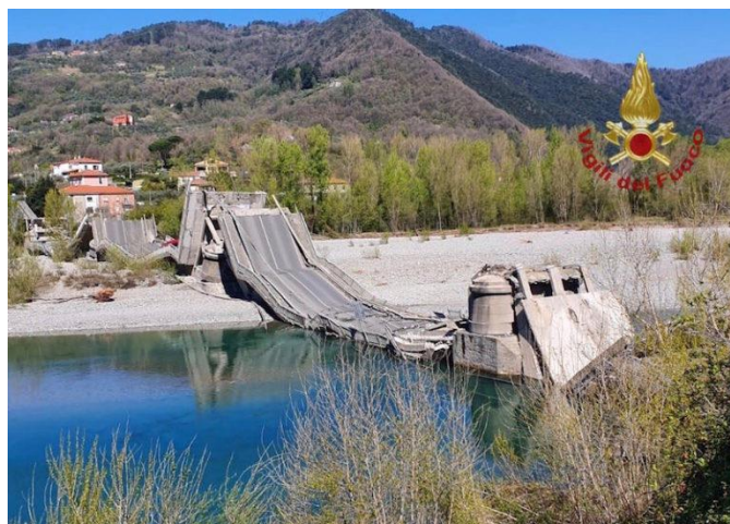
Figg.77 e 78. Cedimenti recenti: sulla sinistra ponte sul fiume Paglia (2.3.2020) e sulla destra sul Magra in località Albiano lungo la Sp70 (8.4.2020) Solo mancanza di manutenzione o anche l'abbassamento dell'alveo ha contribuito a rendere instabile l'intera struttura?
