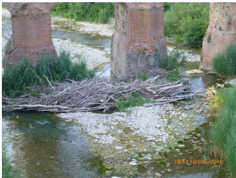
Fig. 18. 10.7. 2016 piloni del Ponte di Pianoro Vecchio
