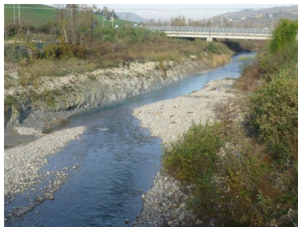
Fig.23. 30.11.2015; erosioni di sponda e incisione dell'alveo del Savena (dalla Passerella della Boaria); sullo sfondo il Ponte della Boaria (BO) i cui piloni potrebbero essere soggetti agli stessi gravissimi problemi che hanno interessato il P.te di V. Serrabella
