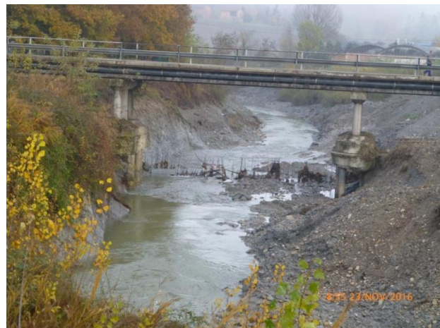
Fig.27. 23.11.2016; il ponte di V. Serrabella viene chiuso; iniziano i lavori di consolidamento
