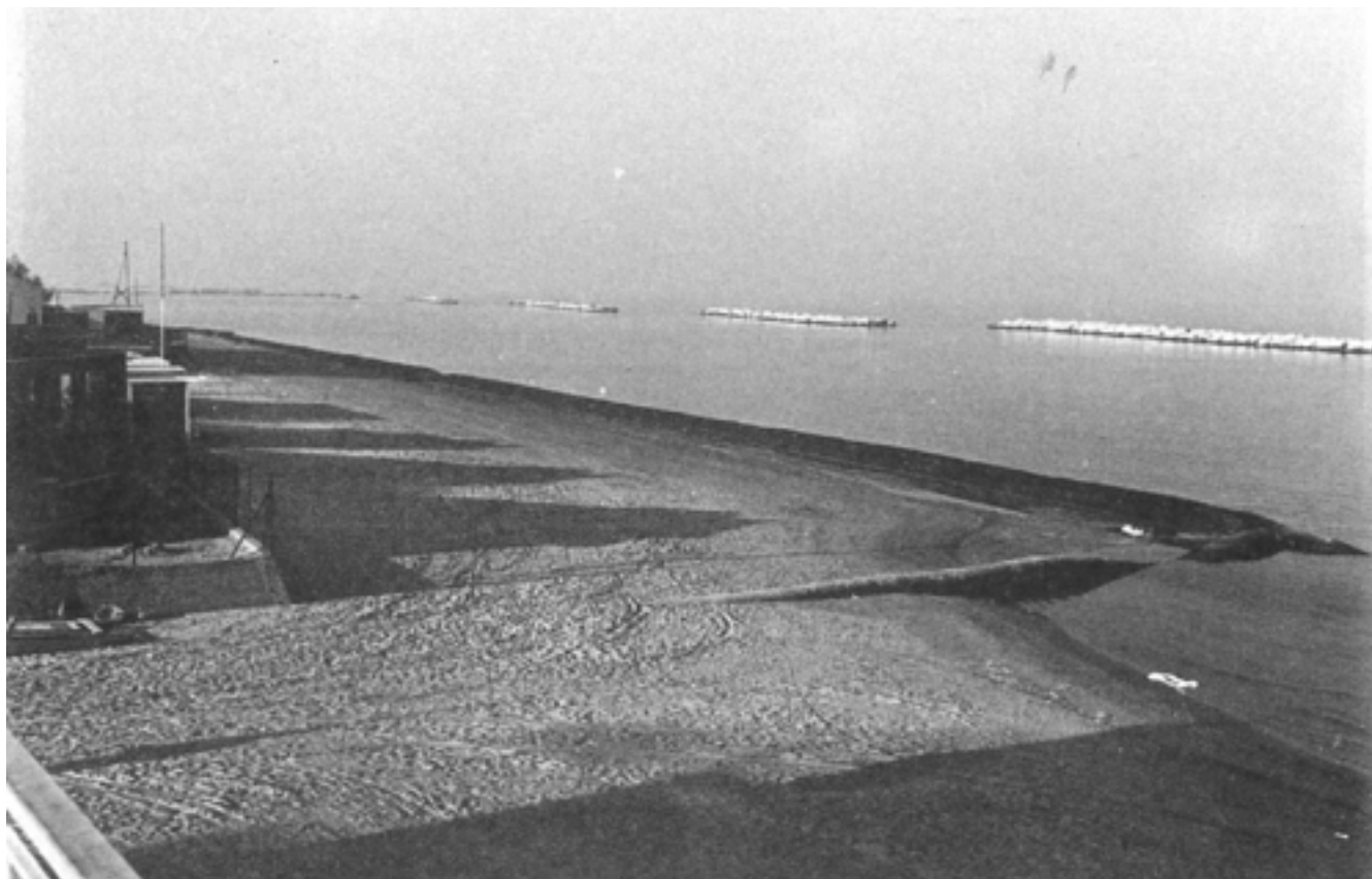
FIGURA 10 San Mauro a Mare: sistema di protezione della spiaggia costituito da scogliere parallele emerse, tubi Longard e ripascimenti (Regione Emilia-Romagna, 1984).
