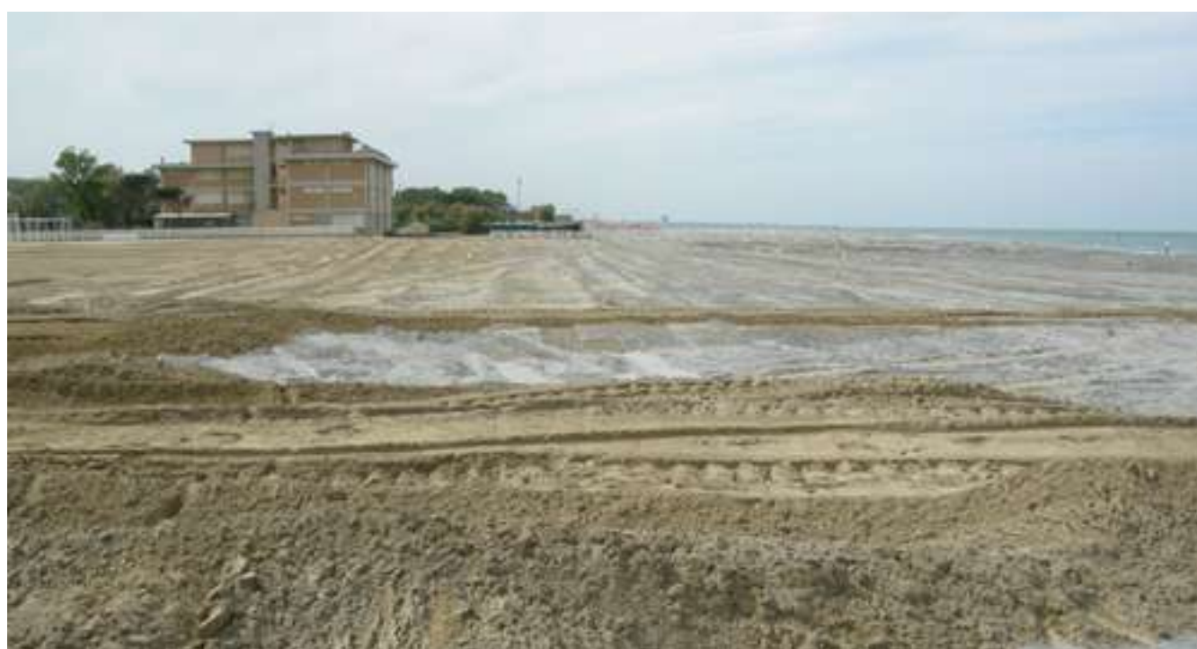
FIGURA 138 Cesenatico Colonie (cella 51): spiaggia in erosione (in alto 30/09/2015 e al centro 15/11/2015), ripristino della spiaggia in seguito al ripascimento con sabbie sottomarine del 2016 (in basso 25/05/2016).
