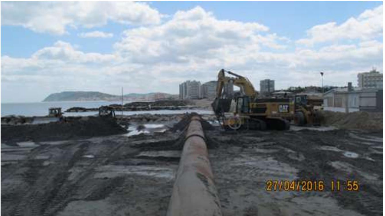
FIGURA 105 Misano: operazione di ripascimento e profilatura della spiaggia (aprile 2016).
