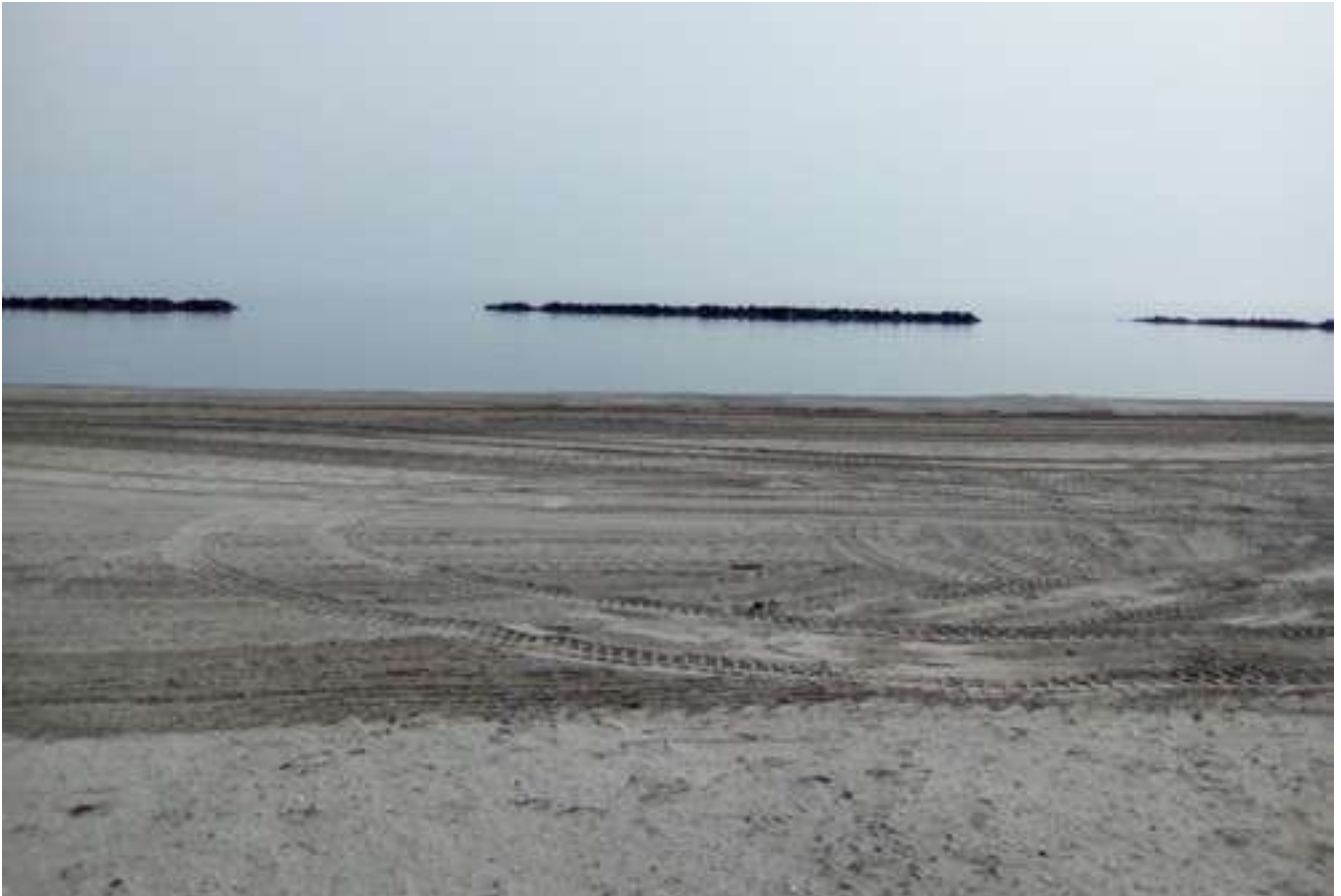
FIGURA 178 Lido degli Scacchi (C103): scogliere parallele emerse a difesa della spiaggia (aprile 2019).
