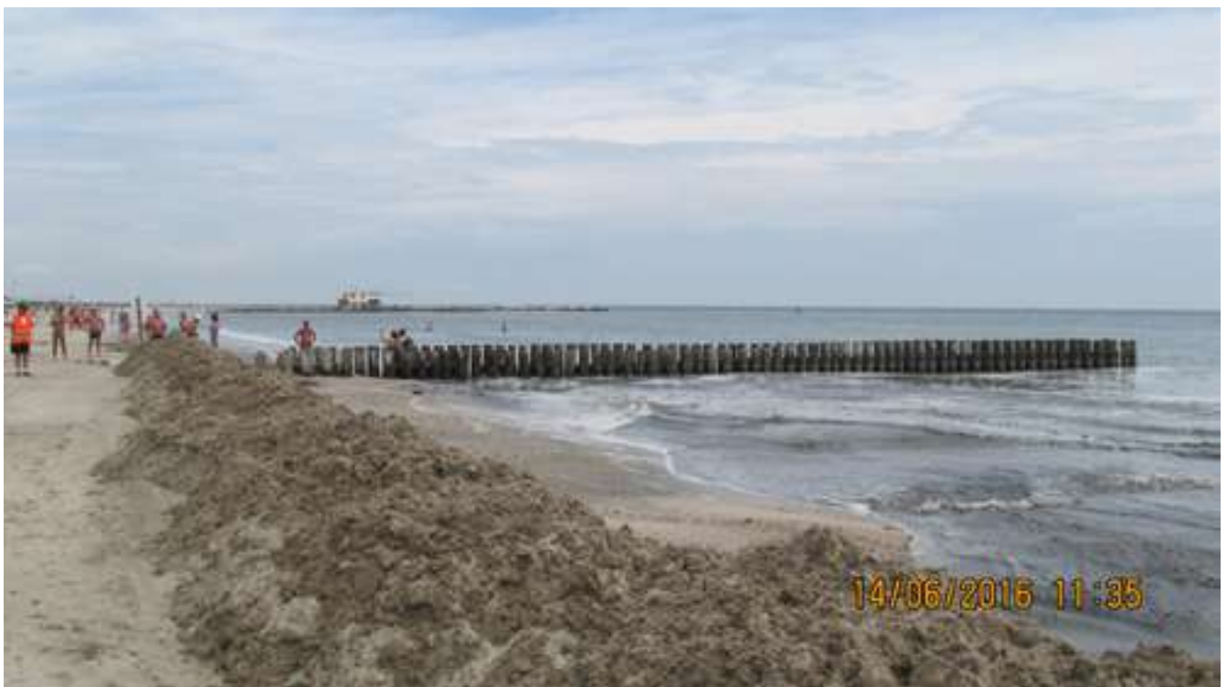
FIGURA 140 Milano Marittima Colonie (cella 61): pennello in pali di legno (14/06/2016).
