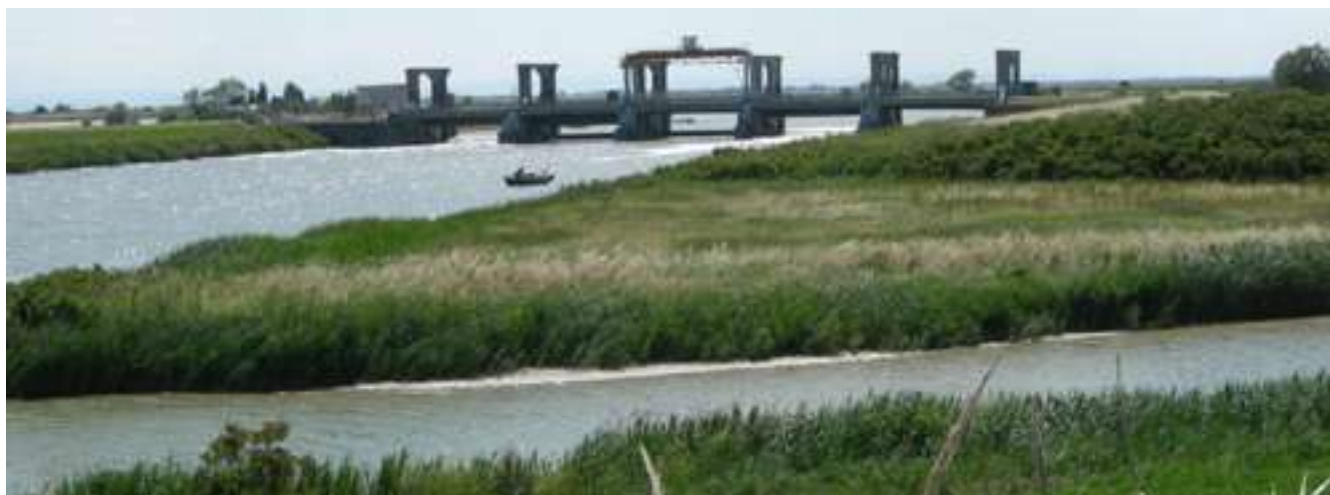
FIGURA 2 Fiume Reno: sbarramento di Volta Scirocco (18 maggio 2015).
