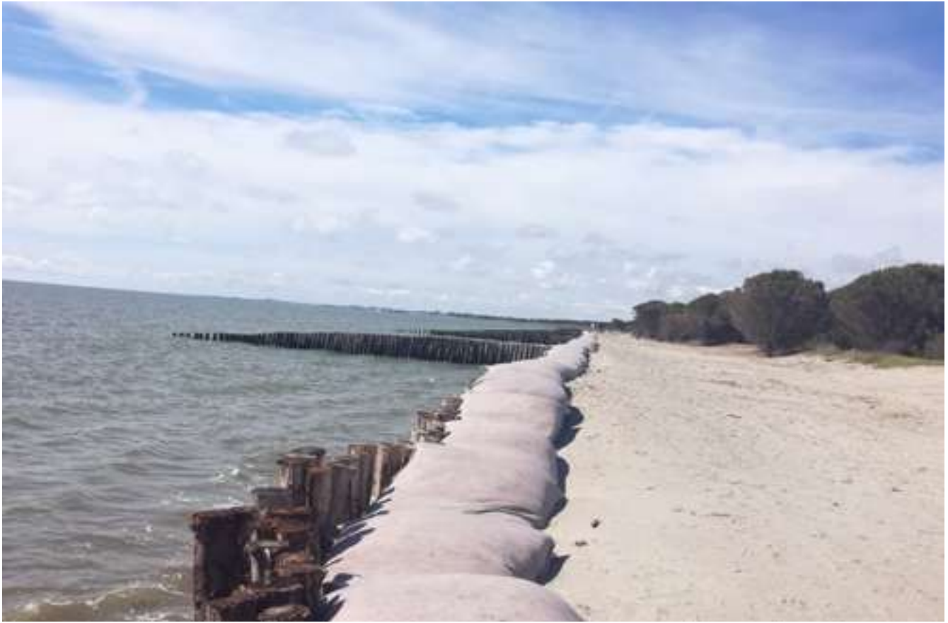
FIGURA 180 Volano Zona Pennelli (C108): sistema di difesa della spiaggia (maggio 2019).
