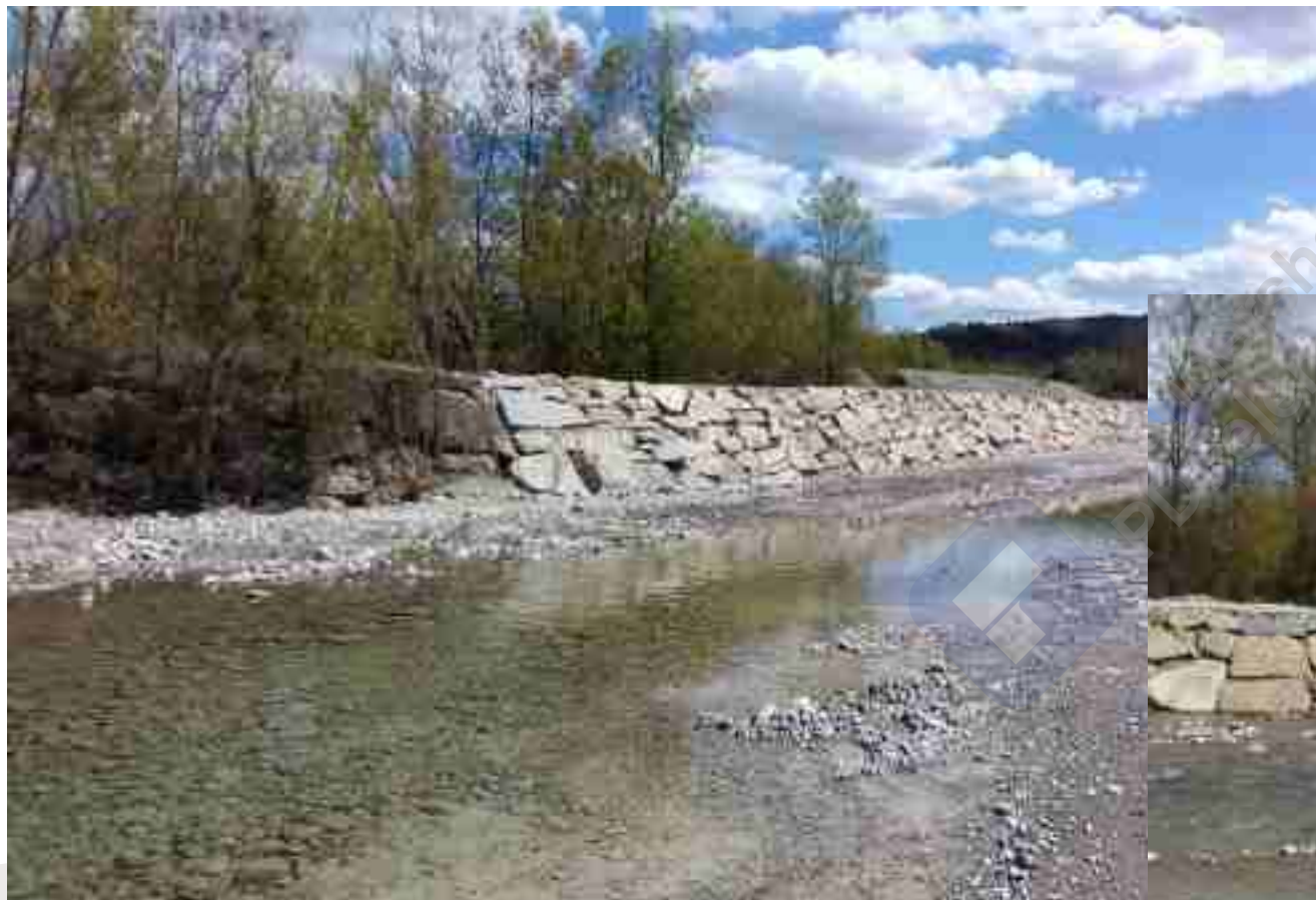
T. Enza dx Idraulica - Loc. Ciano d'Enza Comune di Canossa: Opere di difesa spondale in massi ciclopici tratto di monte
