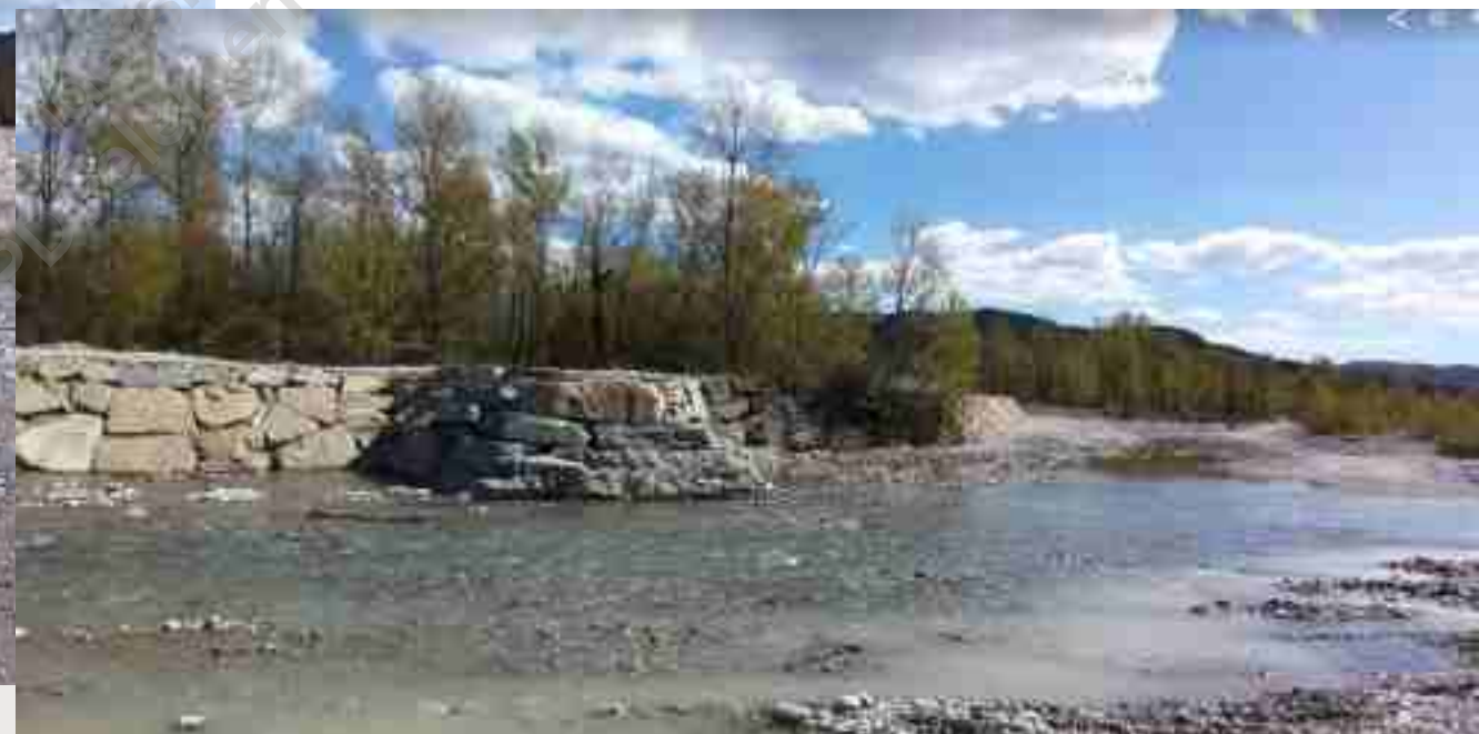
T. Enza dx Idraulica - Loc. Ciano d'Enza Comune di Canossa: Difesa spondale costituito da repellente in massi ciclopici
