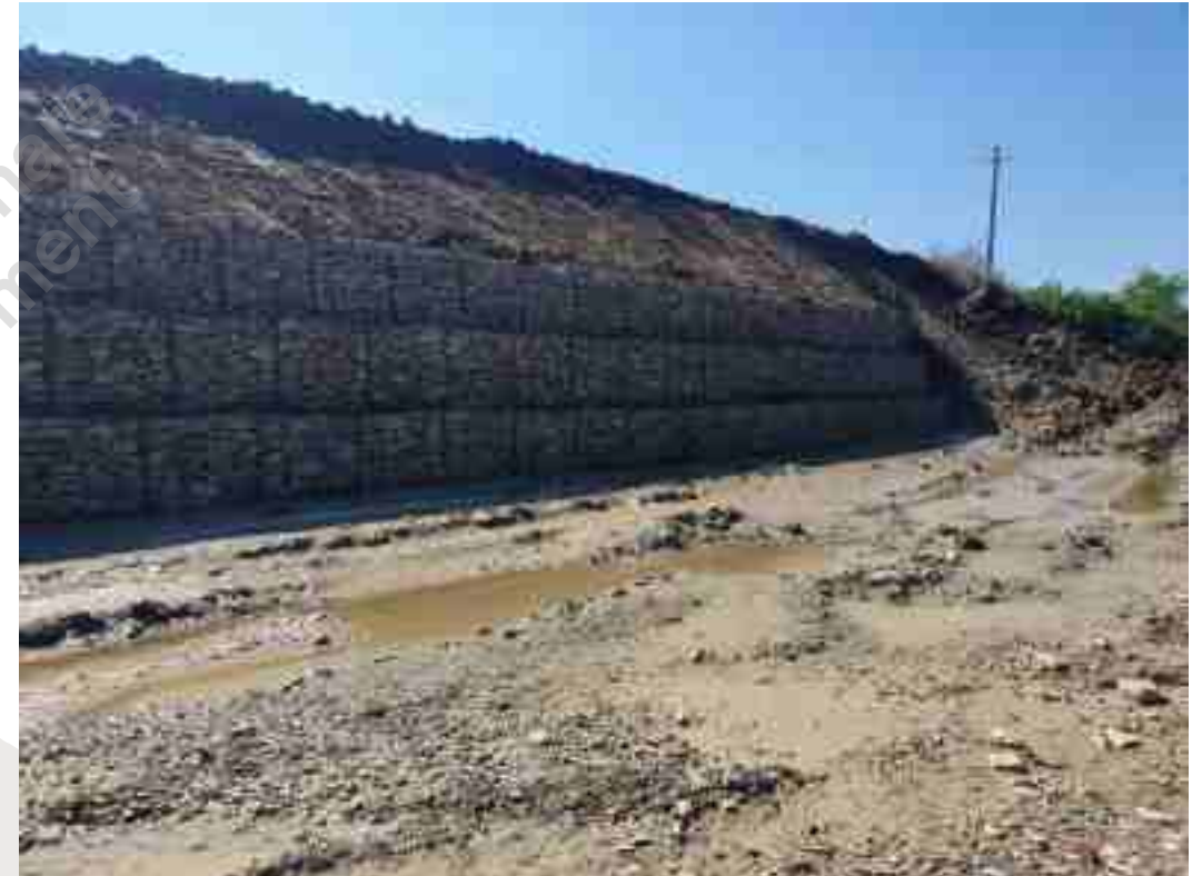
Fotografia del medesimo tratto in fase di esecuzione dei lavori (data 4/09/2020)
