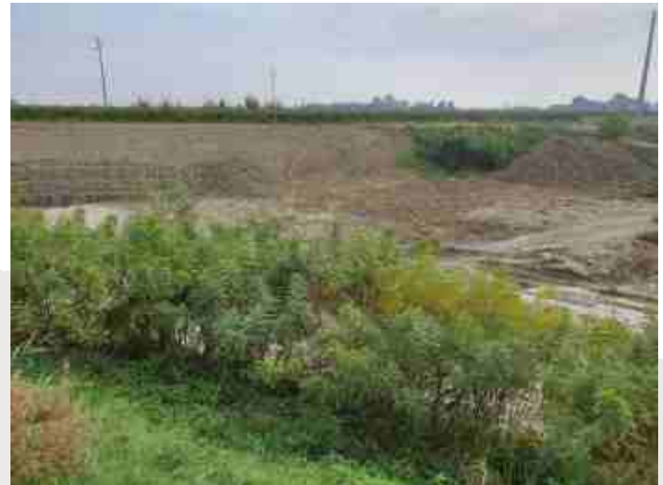
Medesimo tratto in loc. Arceto ( Dopo i lavori, cantiere in corso)
