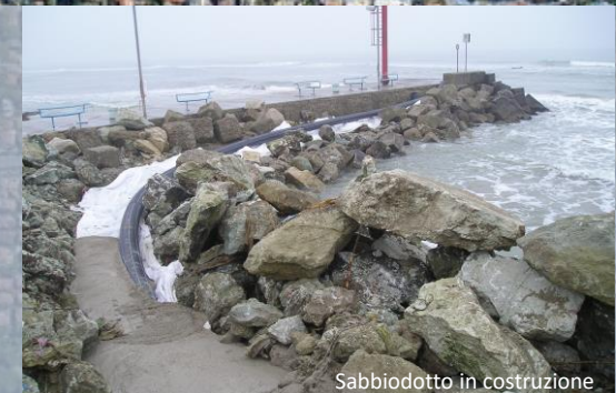
Sabbiodotto in costruzione
