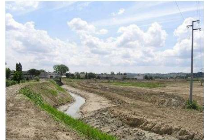
Figura 19 – Subito dopo i lavori sul torrente Cesuola a Case Castagnoli, ove demolito argine sinistro (foto da valle)
