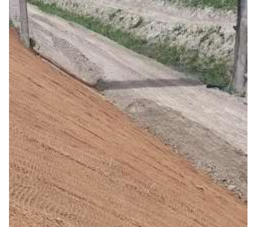
T. Santerno interventi di consolidamento argine sx S. Maria in fabriago
