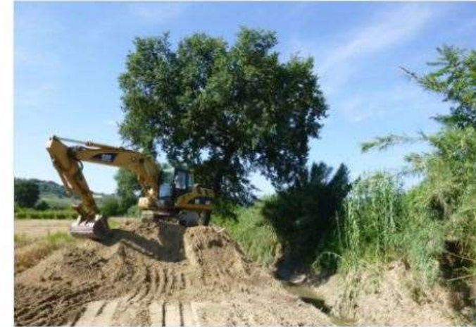
Figura 17 – Demolizioni degli argini sul torrente Pisciatello nel tratto collinare (Calisese)
