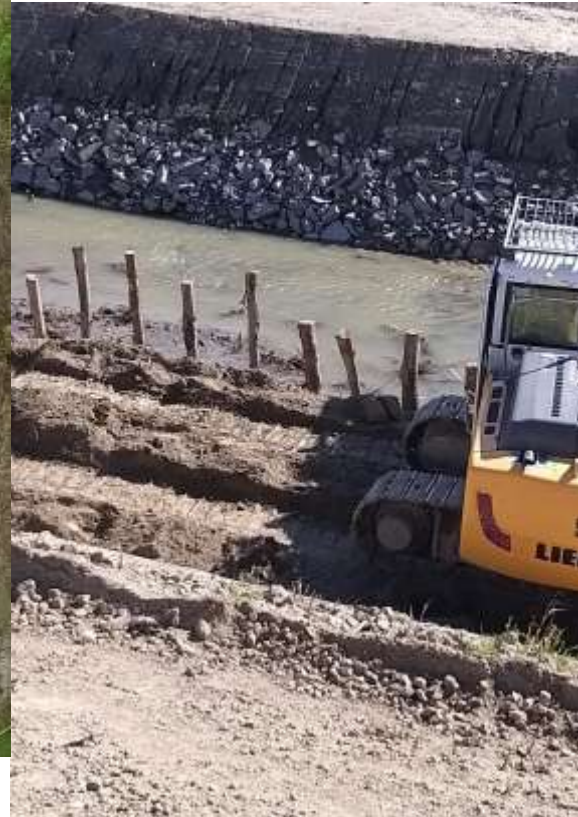
T. Santerno interventi di consolidamento sponda Località ca di Lugo
